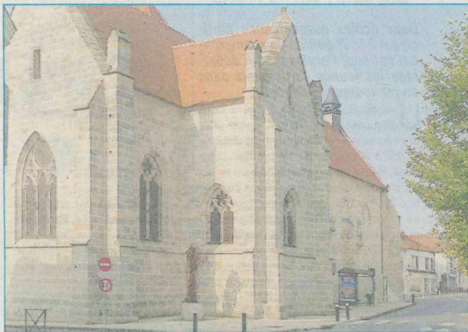
©Ville de Marcoussis. L'église Sainte-Marie Madeleine est de nouveau accessible au public, après quatre années de travaux.
