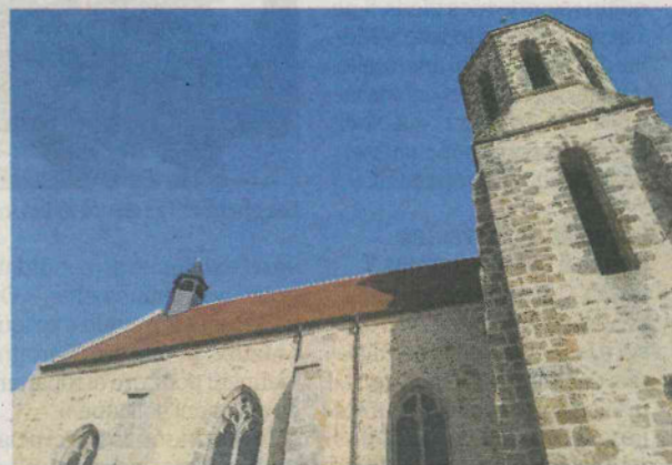
Marcoussis, jeudi. À l'extérieur, les artisans ont essentiellement travaillé sur la façade, le toit et le clocher.
