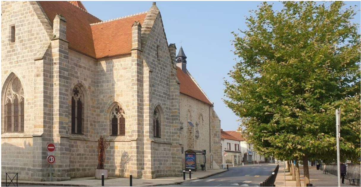
Les travaux de rénovation extérieurs de l'église ont débuté le 31 janvier 2022. (©Ville de Marcoussis)
