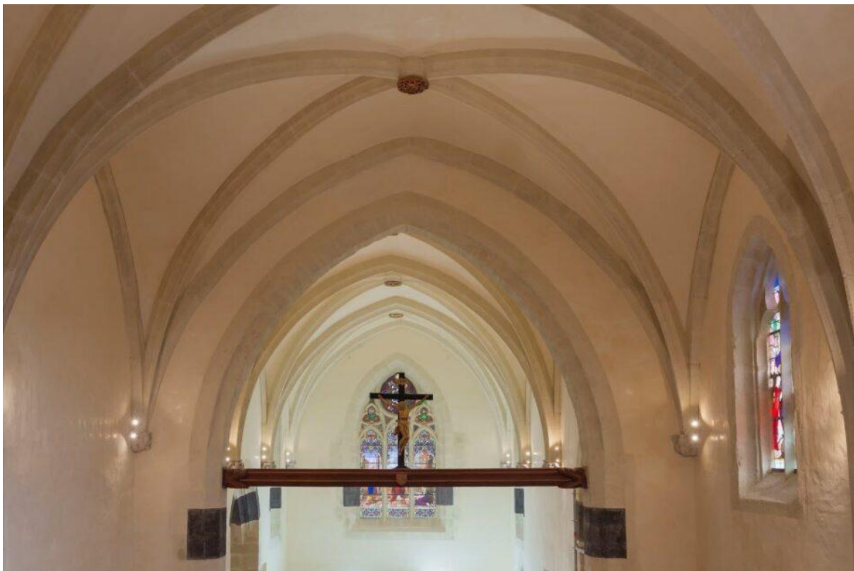
Trois entreprises, notamment spécialisées dans la maçonnerie et l'électricité, sont intervenues à partir de mars 2024 pour la deuxième phase de travaux, à savoir la rénovation intérieure de l'église. (©Ville de Marcoussis)
