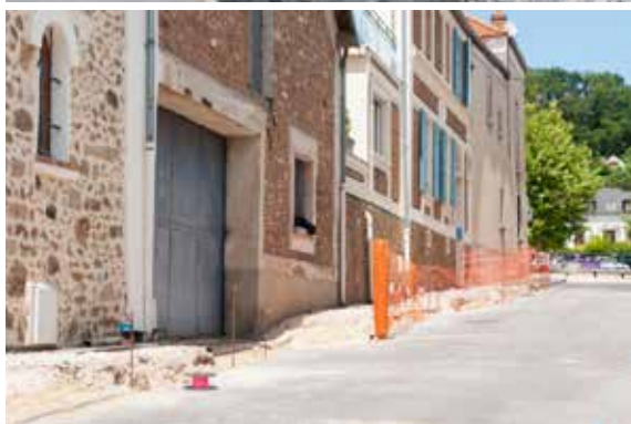
Réfection de la rue Pasteur
