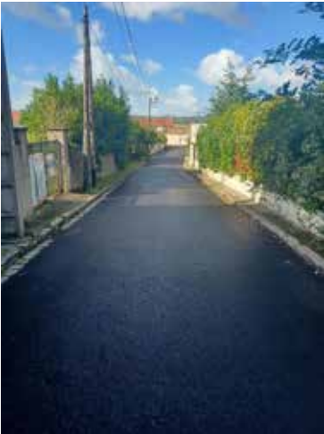
Reprise de la couche de roulement - rue Voltaire
