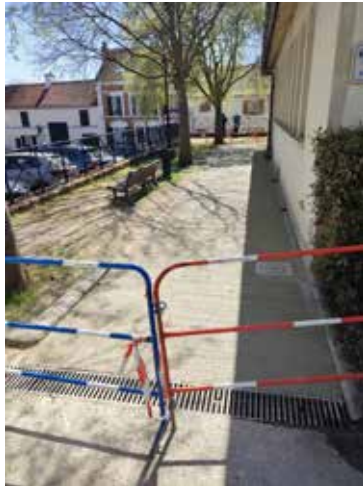
Création d'une rampe pour personnes à mobilité réduite Promenade Victor-Hugo
