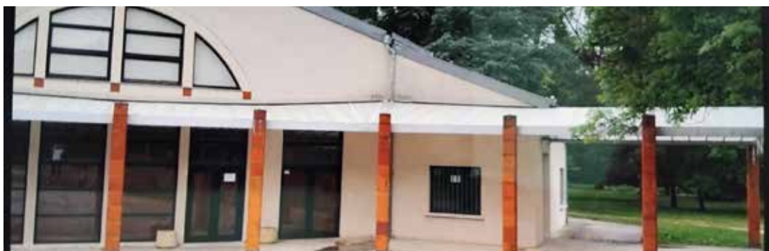
Nettoyage de la verrière de la salle Atmosphère - Espace culturel Jean-Montaru
