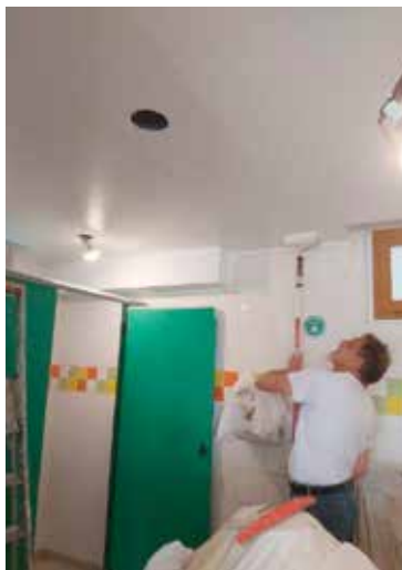
Remise en état du plafond dans les toilettes de l'école des Acacias
