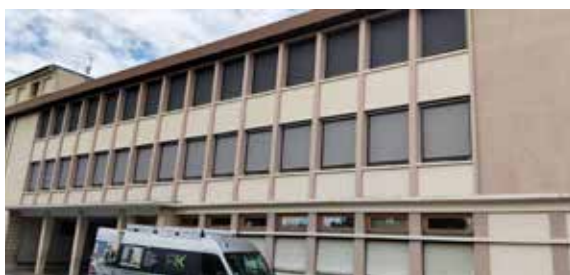
Pose de brise-vues thermiques sur la façade de l'école des Acacias
