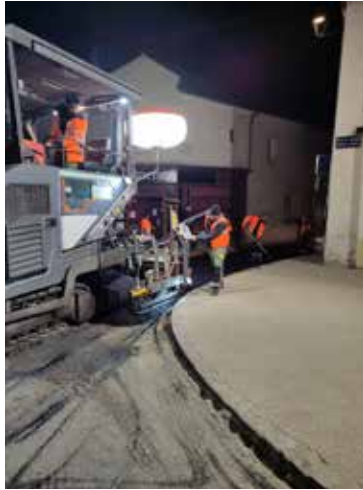
Pose de l'enrobé place du Souvenir
