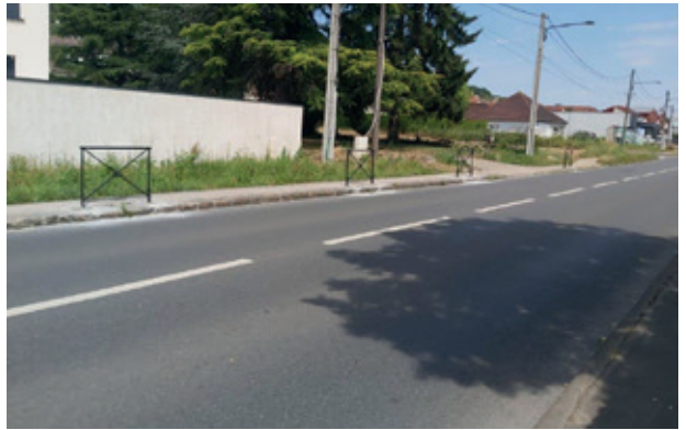
Pose de barrières de sécurité route de Montlhéry
