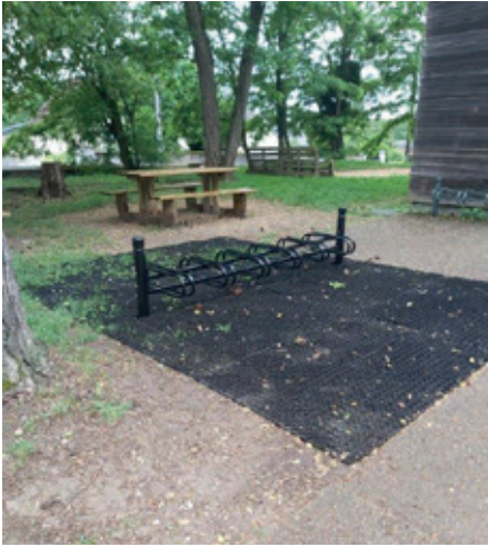
Pose d'arceaux pour la création d'un parking à vélo devant le Service jeunesse
