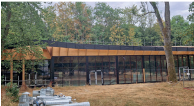
Avancement des travaux de la salle des fêtes
