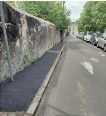
Réfection du trottoir rue des Acacias
