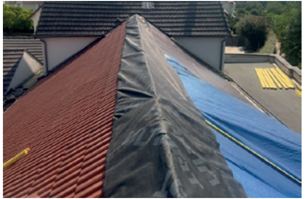
Réfection de la toiture du restaurant scolaire Jean-Jacques Rousseau
