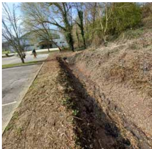
Nettoyage du fossé du parking du complexe sportif du Grand parc
