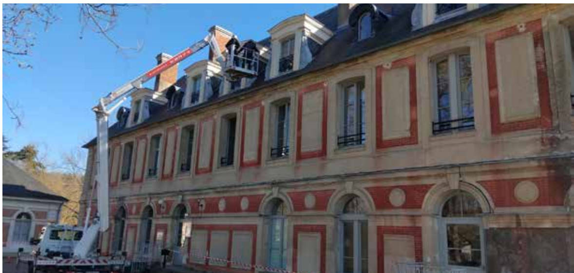
Réparation de la toiture du château des Célestins
