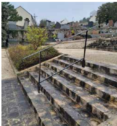
Installation d'une rampe dans les escaliers du cimetière des Acacias
