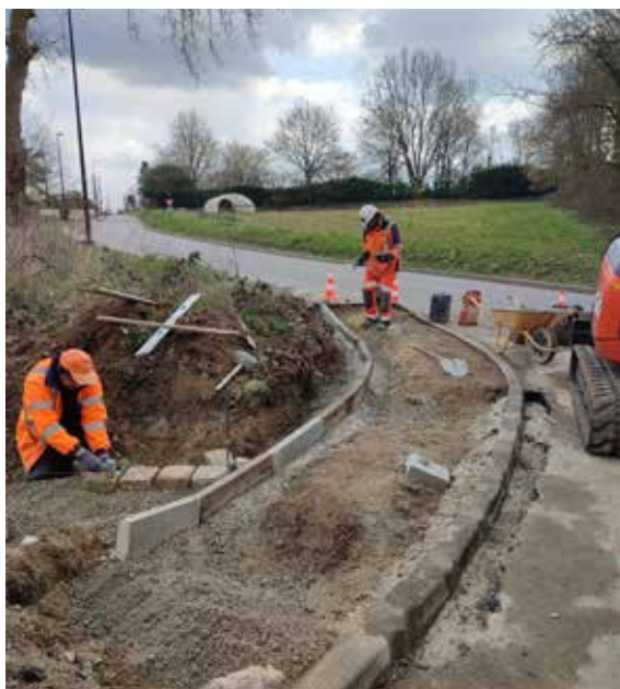
Création d'un trottoir par l'entreprise TPE route du Chêne Rond
