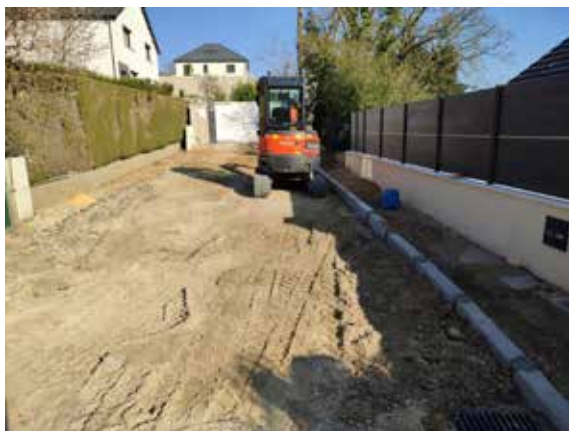
Création d'un trottoir et réfection de la voirie rue du Houssay
