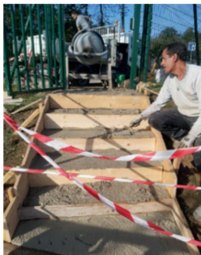
Création d'un escalier au stade du Moulin
