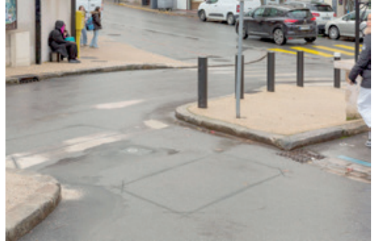
Installation d'une borne escamotable place de la République pour sécuriser le marché
