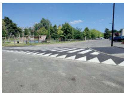
Création d'un dos-d'âne au croisement de la rue des Vieux Gagnons et de la rue de la Chaussée
