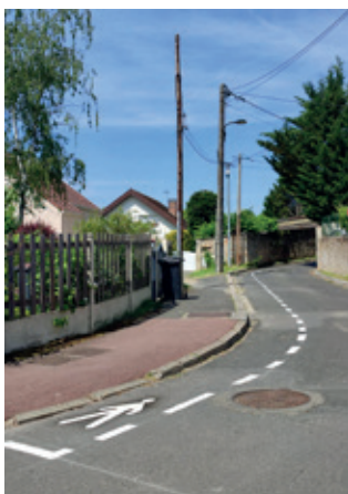
Marquage d'un chemin piéton rue de la Chaussée
