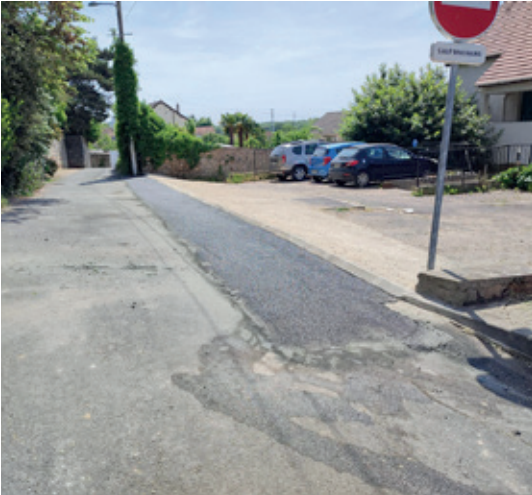
Réfection des bordures pour la création d'un fil d'eau, chemin du Rempart
