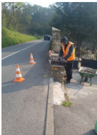
Réparation du mur du cimetière des Acacias
