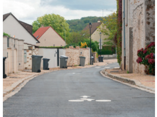
Réfection de l'enrobé rue Gambetta
