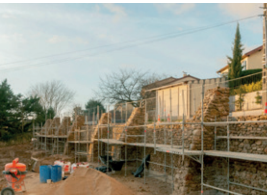
Poursuite de la rénovation du mur de soutènement du Cœur du village
