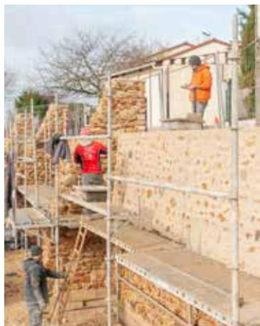
Application d'enduit sur le mur de soutènement de l'îlot de fraîcheur
