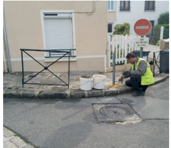
Remise en état des panneaux et barrières entre la rue Jean-Dubocq et l'impasse Jean-Jacques-Rousseau
