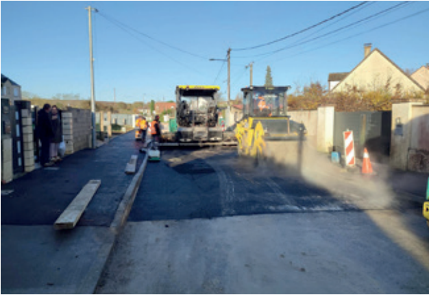
Travaux de réfection de la rue Eugène-Moutard-Martin
