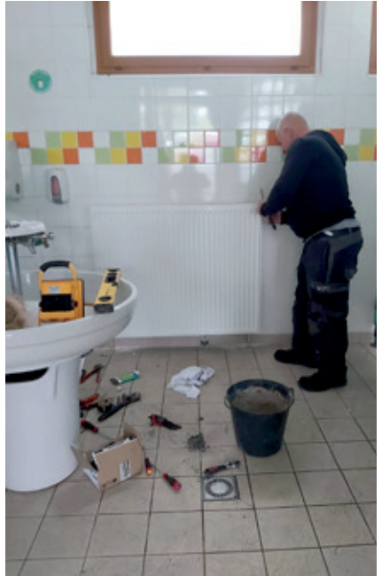
Changement des radiateurs dans les sanitaires de l'école des Acacias
