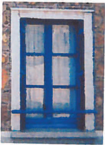
Fenêtre ouvrant à la française, à 3 carreaux, en bois peint
