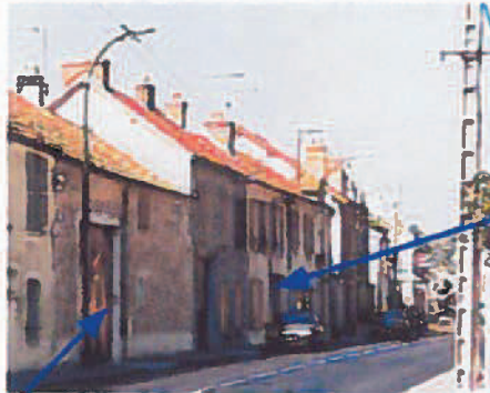
Bâti de centre ancien
